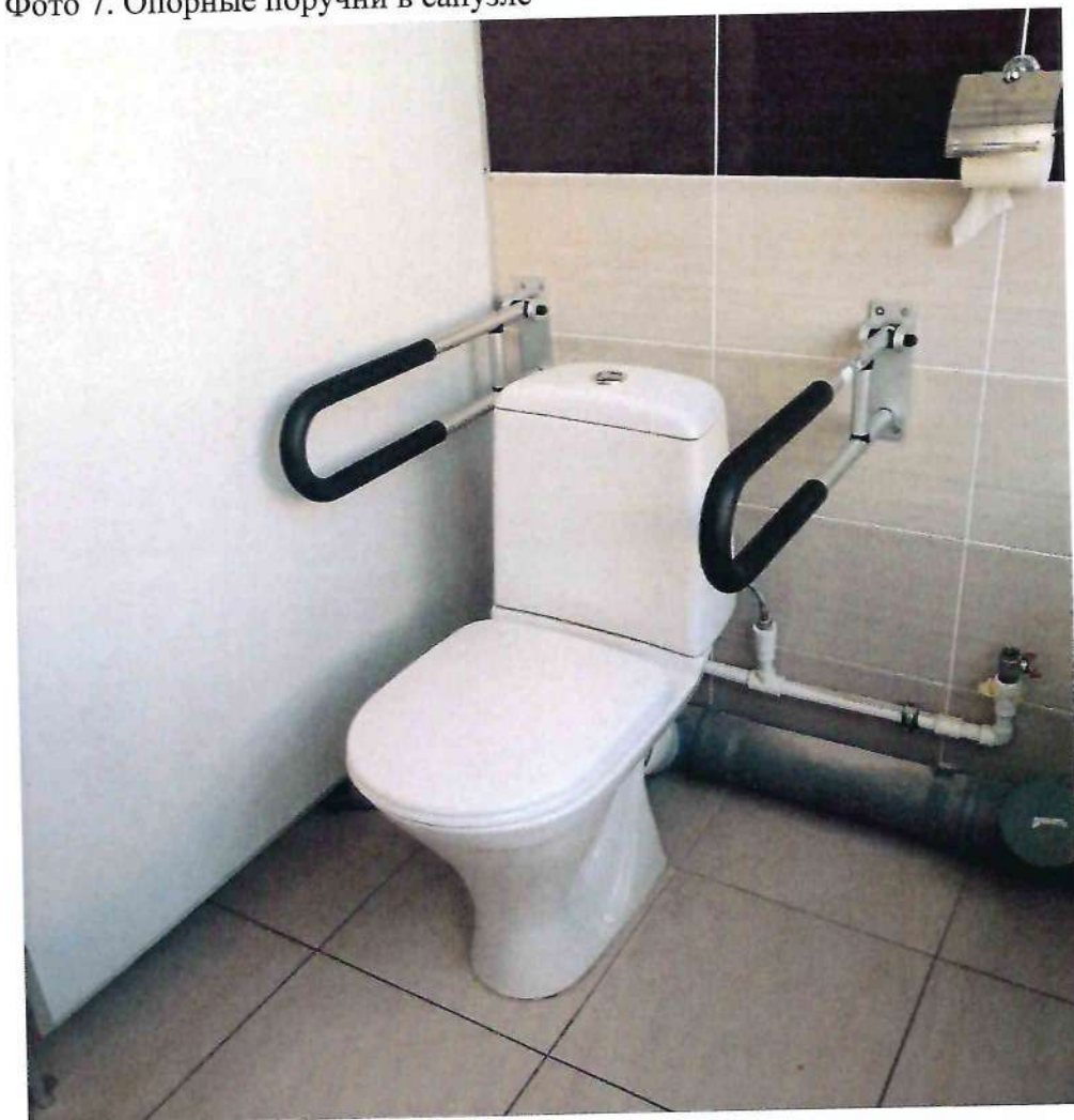
Фото 7. Опорные поручни в санузле
